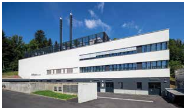
Abb 29: LKH-Univ. Klinikum Graz, Energiezentrale © Markus Kaiser
