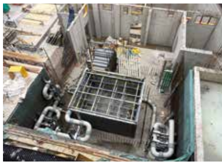
Das Zyklotron wird im Würfel positioniert, rundherum wurden danach 2,7-Meter-Betonwände gegossen.
