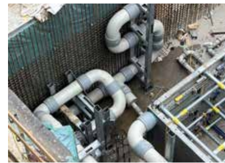
Die Lüftungsleitungen in den Wänden verlaufen in Mäandern – zum Abklingen der Strahlung.
